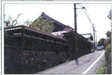
64 元本陣 道を挟んで庭園が残る。
